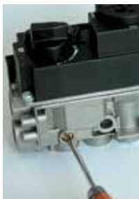
Abb. 15. Einstellen der Mindesthöhe der Flamme des Hauptbrenners
